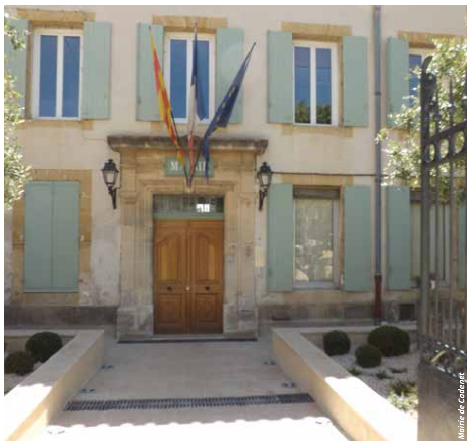
La mairie après travaux.
