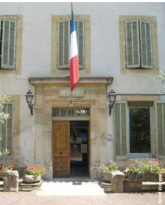
La mairie avant travaux
