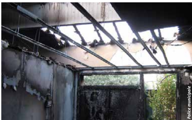
Dégât de l'incendie à la maternelle, le 2 août 2014.
