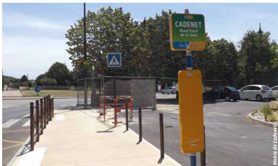
Un abri bus est en construction au rond-point de la gare.
